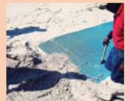
3. Couvrez de sable les extrémités afin d'éviter les risques de chute
