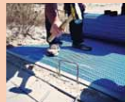
2. Ancrez l'extrémité du PATHMAT avec des cavaliers
