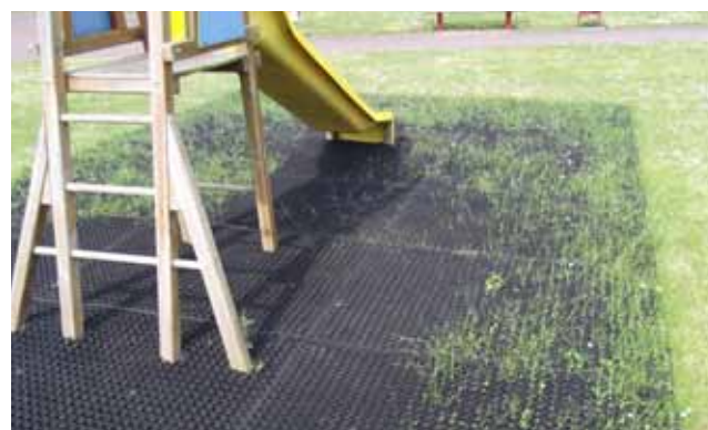
Repousse de l'herbe entre les mailles du sol amortissant 3 semaines après la mise en œuvre.
